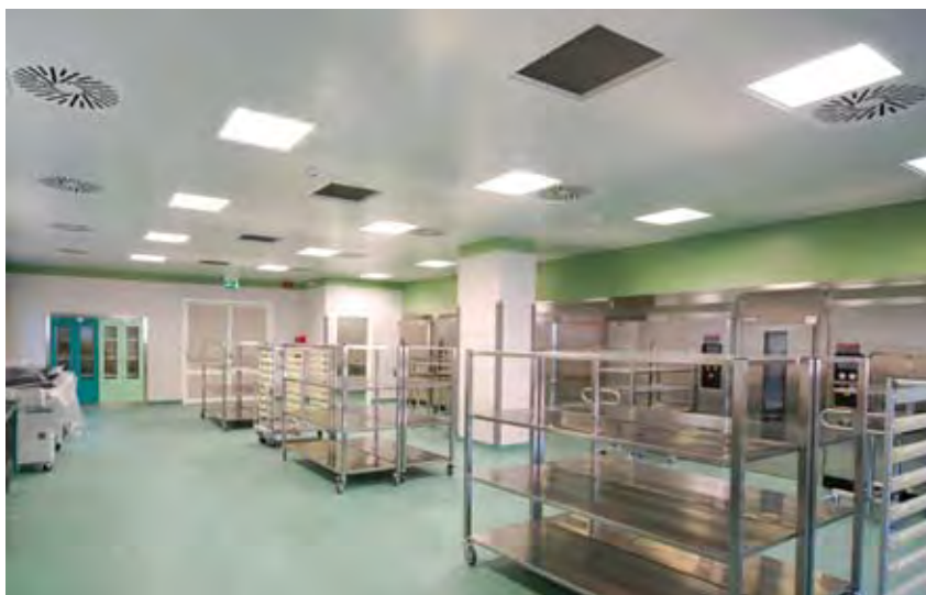
Fig. 5 Area di scarico delle sterilizzatrici con scaffali per lo stoccaggio dei container trattati.
