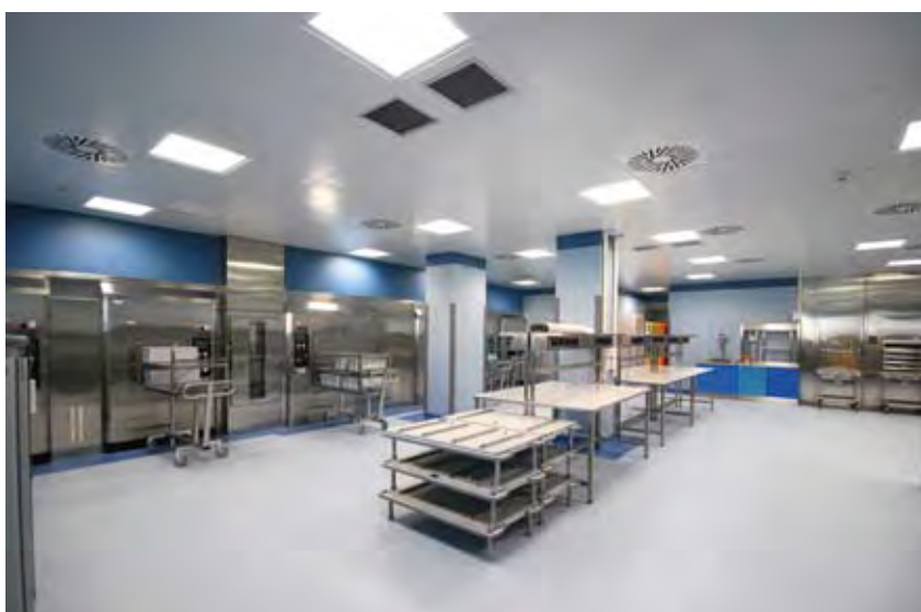
Fig. 4 Area di confezionamento provvista di tavoli da lavoro per la ricomposizione dei set chirurgici e sulla sinistra parete attrezzata con le 6 sterilizzatrici passanti ed un pass box.
