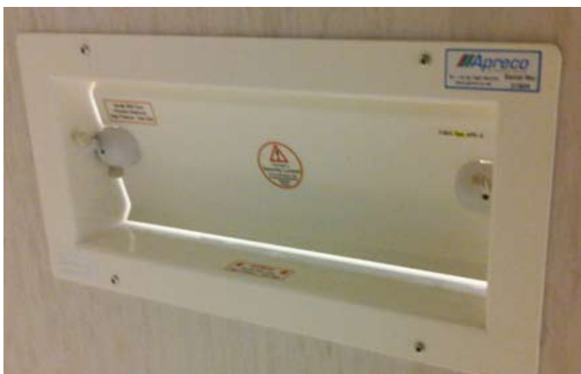
Fig. 6 Stabilizzatore di pressione costituito da uno sportellino che consente il passaggio di aria da un ambiente pulito a pressione maggiore verso un ambiente sporco a pressione minore
