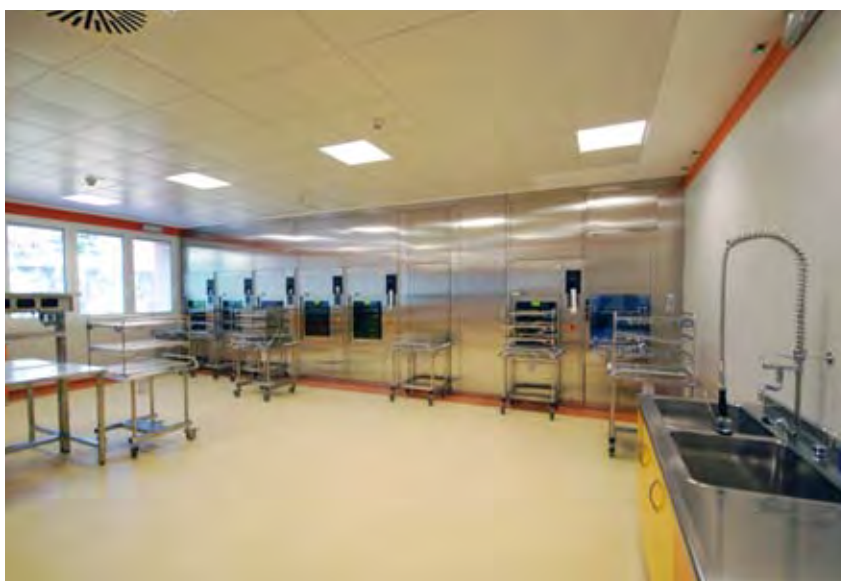
Fig. 3 Parete attrezzata con 6 lavastrumenti passanti e pass-box nell'area di Lavaggio.
