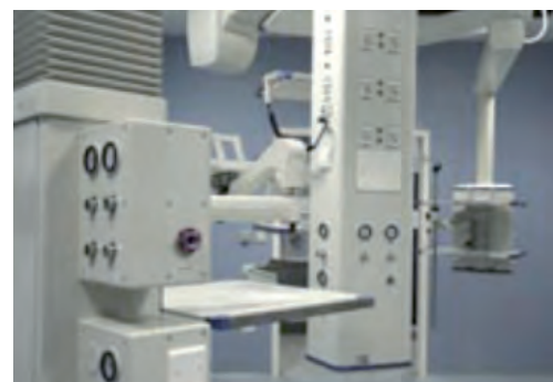
Figura 9. Il sistema dei pensili di sala operatoria
