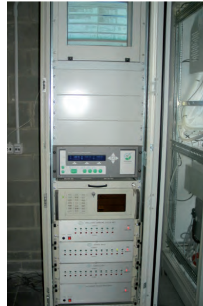
Figura 5. Hardware centrale di elaborazione dei dati del sistema di monitoraggio in continuo
