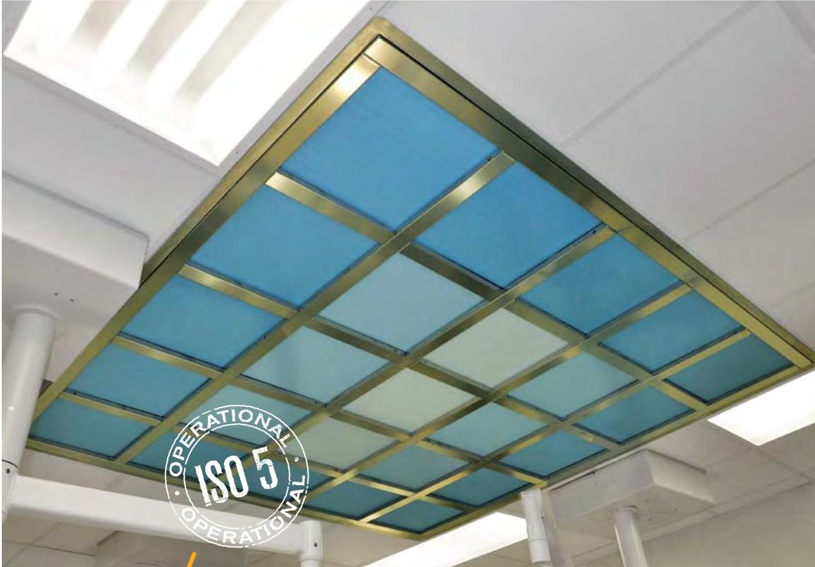
Grazie al flusso a tre velocità differenziate il plafone DIF O.T permette di ottenere un'efficacia superiore ai sistemi a flusso unidirezionale tradizionale
