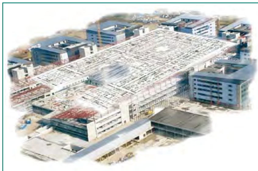
Fig. 3: Vista sul cantiere (Ottobre 2008) a cui è stata sovrapposta la planimetria della piastra operatoria
