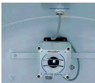
Foto 4 - Particolare del rivelatore di fiamma
